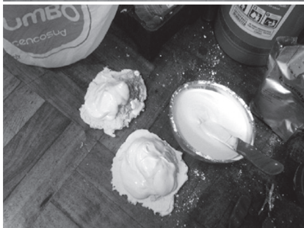
Trabajos de amoldado in situ
